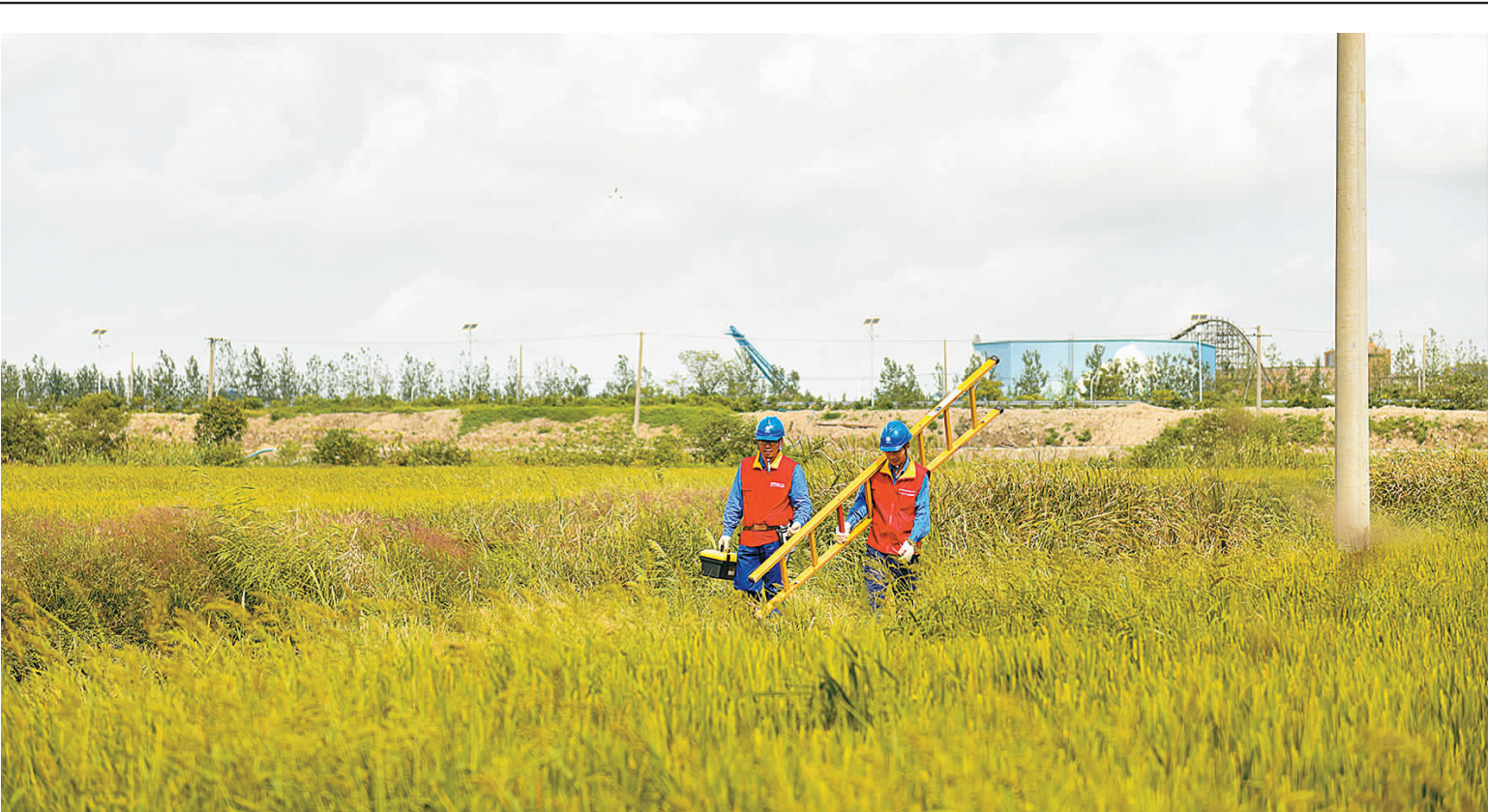
主动服务到田间。日前，国网宁波供电公司杭湾分公司红船党员服务队前往庵东镇东升农场，对农场周边线路、电力设备进行巡视，确保秋收供电平稳有序，助力农户丰产丰收。（记者 黄贵 通讯员 孙洁 摄）
