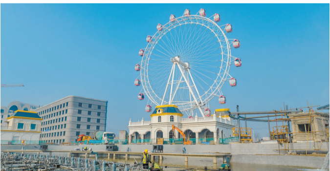
熊出没欢乐港湾项目整体进度超91%，预计2024年建成投用
