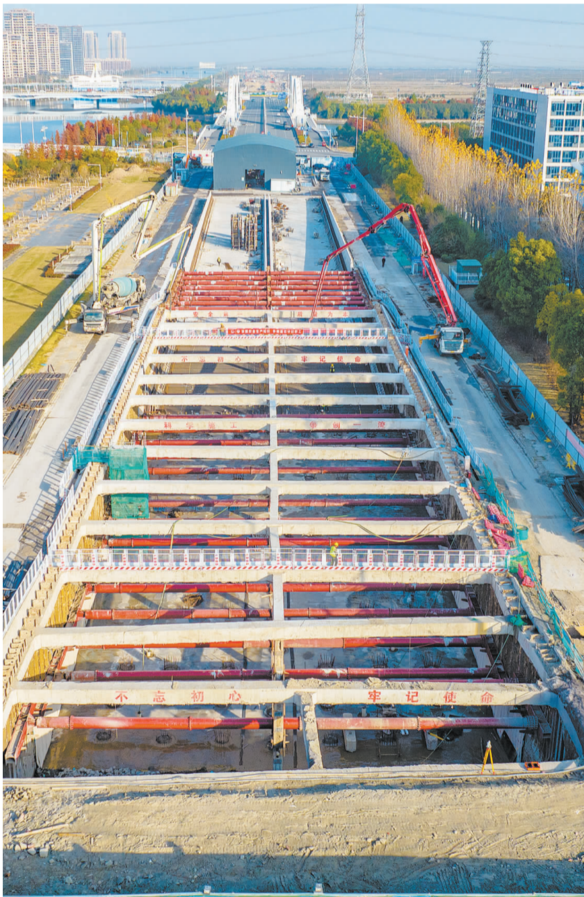
兴慈八路快速路（金慈路—滨海五路）进行冠梁、支撑梁及隧道底板砼垫层浇筑
