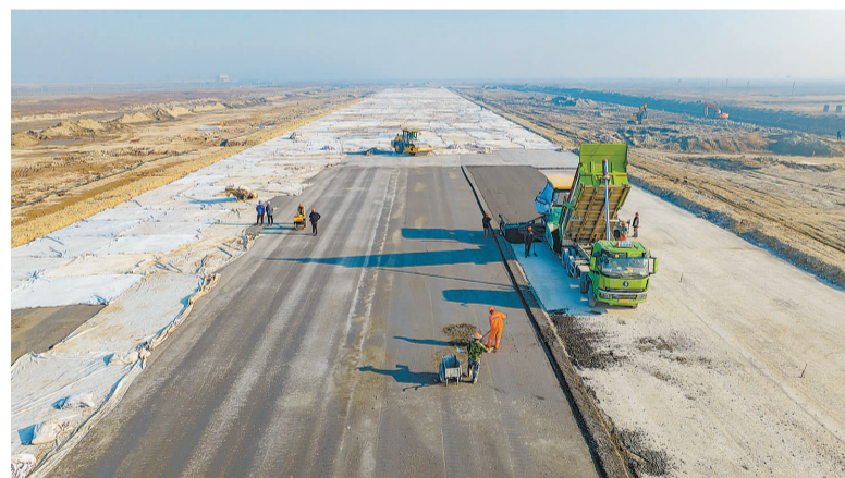
新区通用机场航站区主体施工，预计2024年春节前完成主体结构验收
